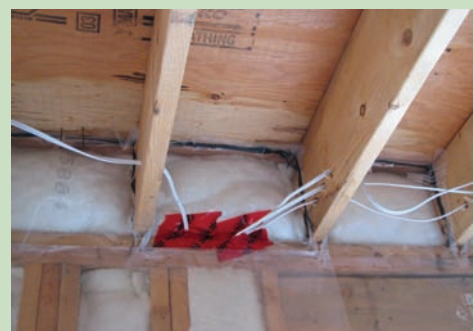
사진 2: 끝막이장선에 단열재를 설치하고, 그 위에 PE 필름을 기밀하게 시공하여 증기막과 기밀막의 역할을 겸하도록 시공함. 그 후 필요에 따라 장선 사이에 단열재를 설치함.
