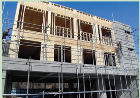
기둥-보구조에 SPF 규격재로 우드월을 만들어 시공: 우드월을 비내력벽으로 외벽에 시공하여 단열효과도 높이며 추가적인 전단력 제공
