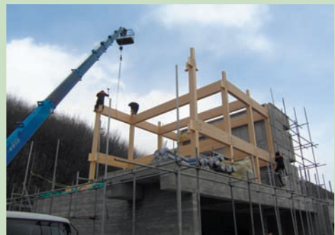
사무실 부분의 중목구조 시공: 공장제작 글루램을 크레인 사용하여 쉽고 빠르게 시공
