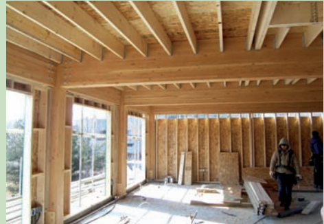
실내에서 본 사무실 공간: 주요 구조부는 글루램으로 기둥-보 구조로 시공, 바닥은 2x10 SPF 규격재 장선, 벽체는 우드월로 설계 시공
